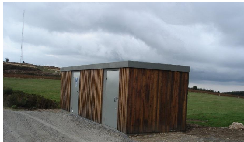
Illustration 13 : Poste de livraison du parc éolien du MARGNES (81)
