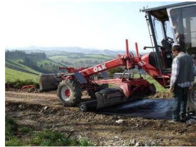
Illustration 21 : Pose du géotextile
