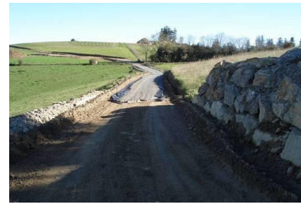
Illustration 22 : Mise en place du gravier
